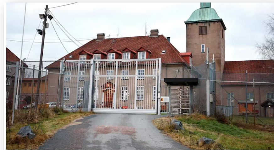
FRYKTER FOR SIKKERHETEN: Kvinnelige innsatte fra Bredtveit fengsel er akuttflyttet til Ullersmo fengsel. Foto: Trond Solberg / VG
